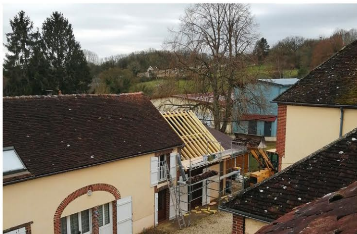
Remaniement des toitures. Photo © S. Marchand
